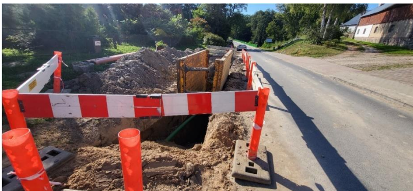
Budowa kanalizacji z Barnimia do Drawna
